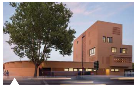
Colegio Agustín Gericó. Arq. Carlos Labarta, José Alfaro y Alejandro Dean. Ejecutado con fachada de ladrillo cara vista autoportante.
