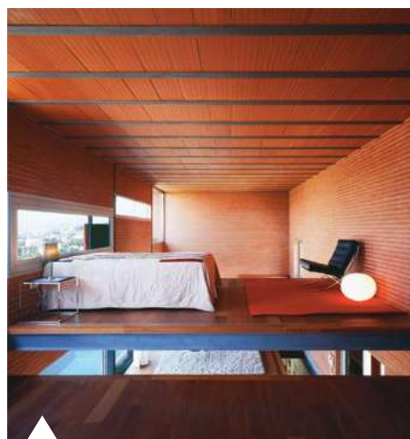
Casa en El Palo (Málaga) con tablero cerámico. Arq. Rafael Reinoso Bellido. Foto: Pablo F. Díaz-Fierros.
