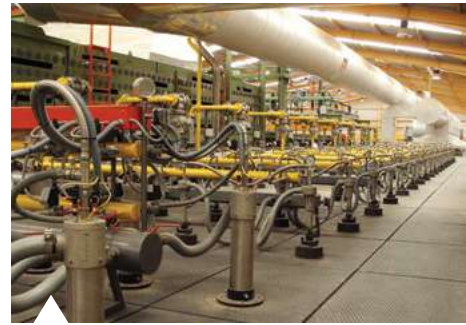
Utilización de biogás en el horno de una fábrica de ladrillo.
