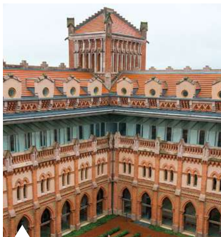
Rehabilitación del seminario mayor de la Universidad Pontificia de Comillas.
